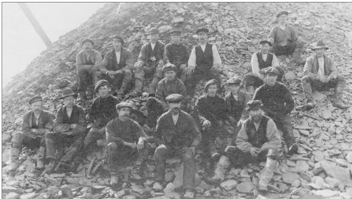
Anleggsarbeidere i Ramsågruva. Disse var trolig tilknyttet Sulitjelma AB i 1918.
